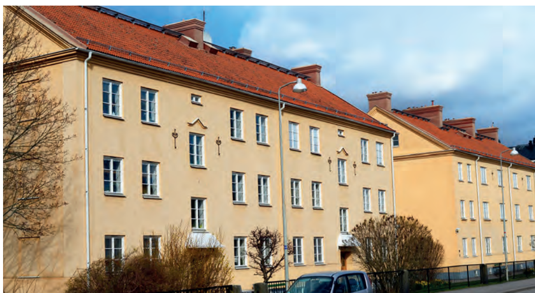
LOGEN Storsvängen 7-1 A-C
